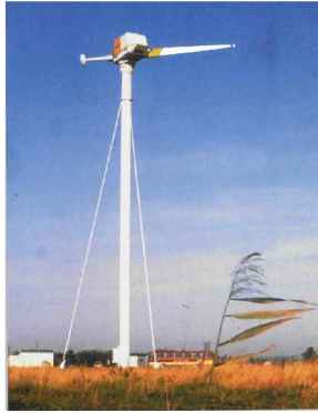
Рисунок 3 – Однолопастная пропеллерная турбина
