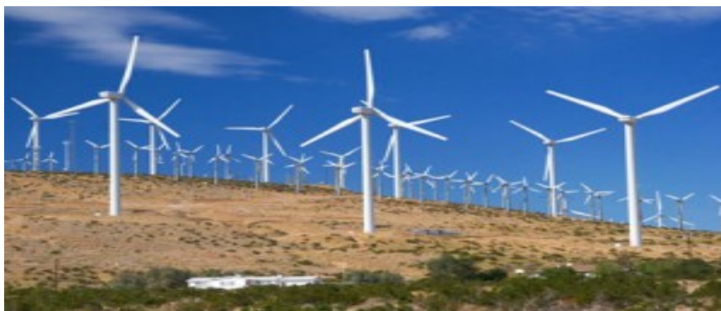
1-сурет. Жел электр станциясы
