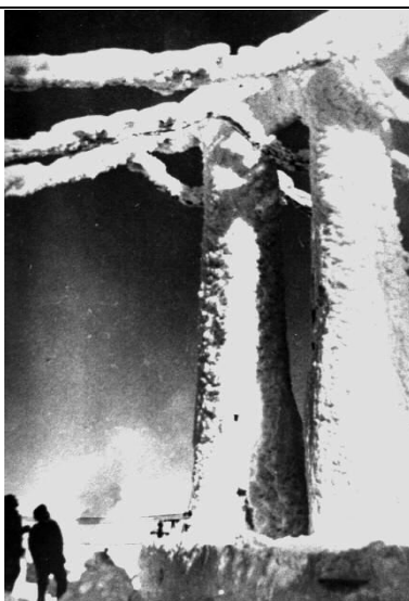
Рис. 3. Состояние линии электропередачи после снежной бури в Павлодарской области.
